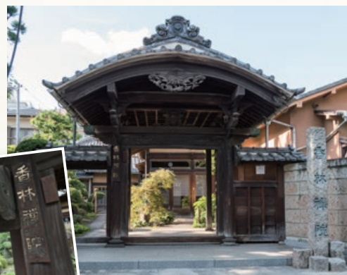
院門、本堂は江戸期の貴重な木造建築である。
